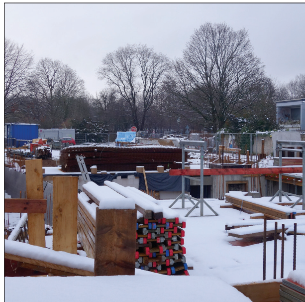
Die Baustelle: Gut, dass der Schnee nicht den Fortschritt verhindern kann. Der Keller nimmt Formen an, bald wird schon die Kellertreppe eingebaut.
