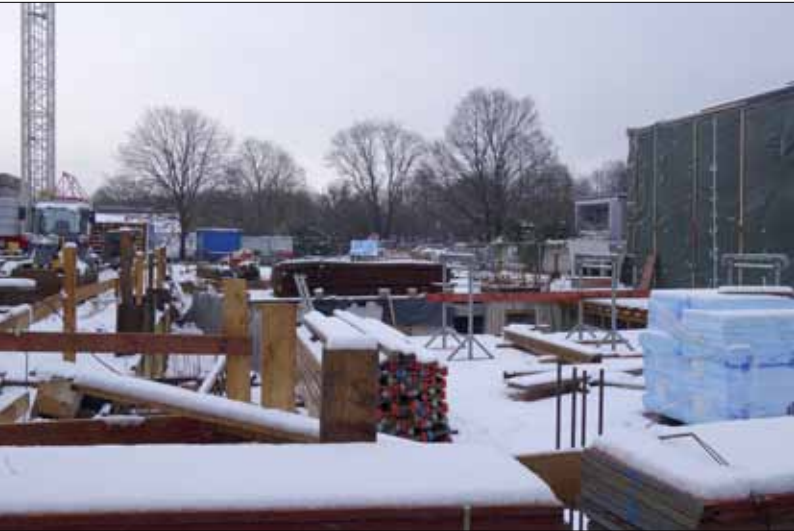
JANUAR 2021 – Baustelle im Schnee
