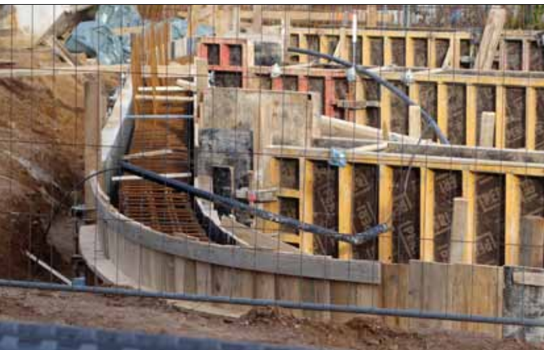
JANUAR 2021 – Das Fundament für den Saal
