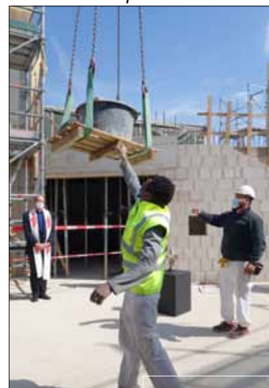
Mörtel für die Zeitkapsel
