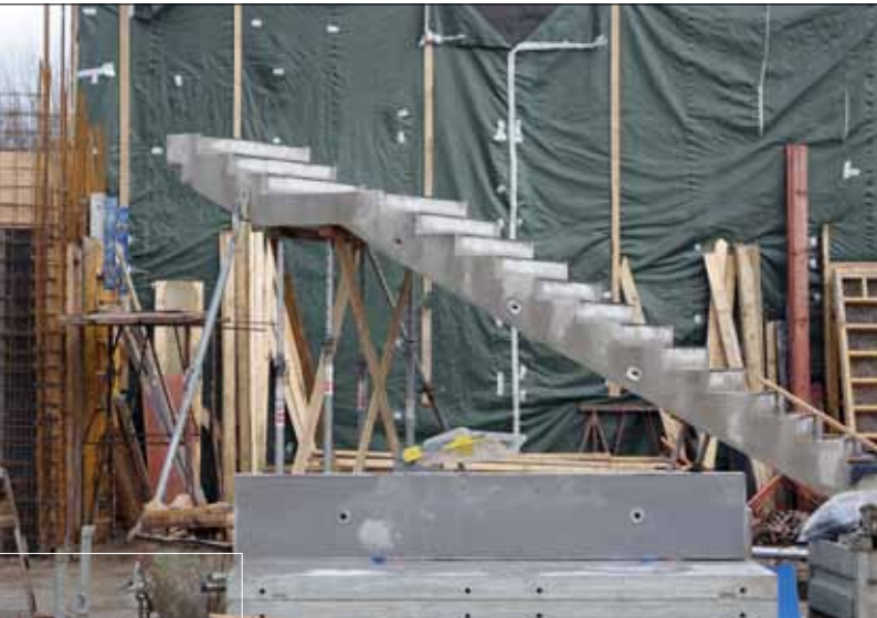
FEBRUAR 2021 – Treppe ins Obergeschoss
